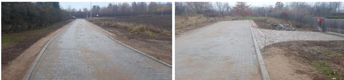
Przebudowa drogi wewnętrznej w Wawrzynach
