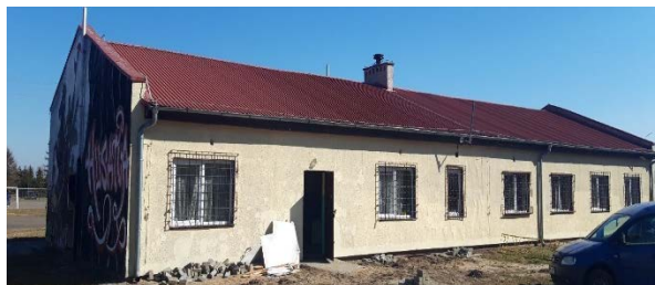
Budynek kultury fizycznej w Kinkajmach w trakcie modernizacji i przekształcenia na remizę strażacką
