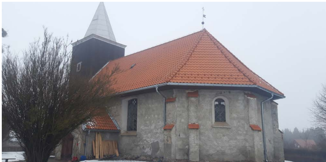
Kościół w Wojciechach po remoncie dachu
